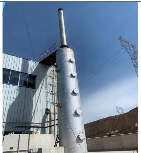
废气处理设施（脱硫塔）及排气筒
