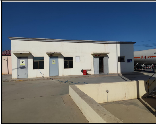
LNG 加气站房
