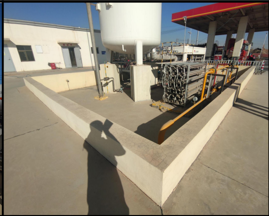
储罐围堰
