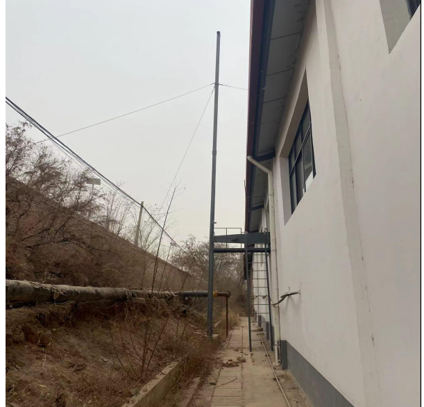
蒸汽吹扫工序废气排气筒
