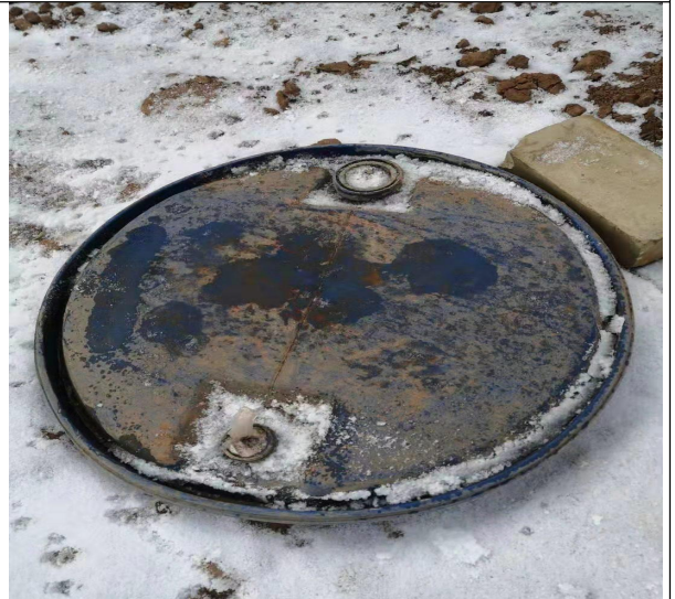
1座 5m 3 化粪池
