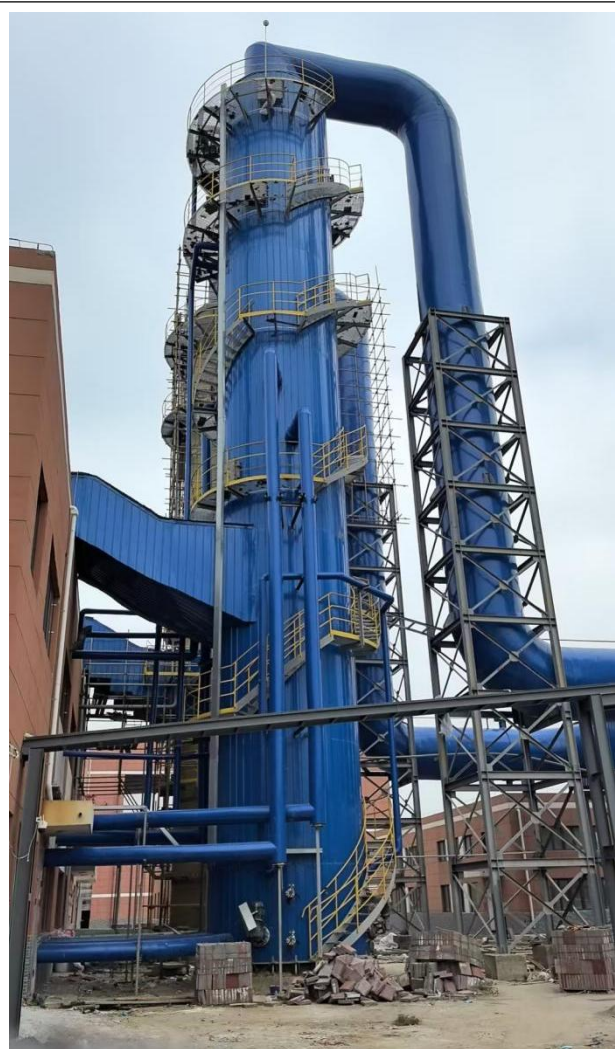
2套石灰-石膏脱硫设施
